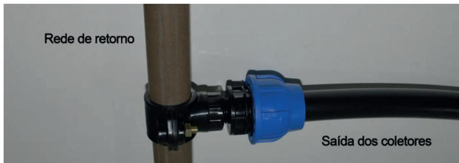
Figura 8: Adaptador unindo saída dos coletores à rede de retorno
